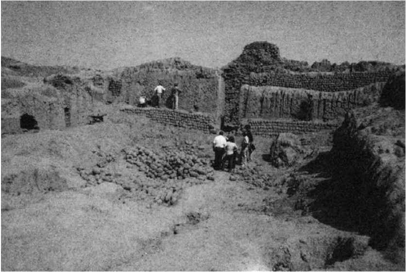
Trabajos de restauración en Chan-Chan.
